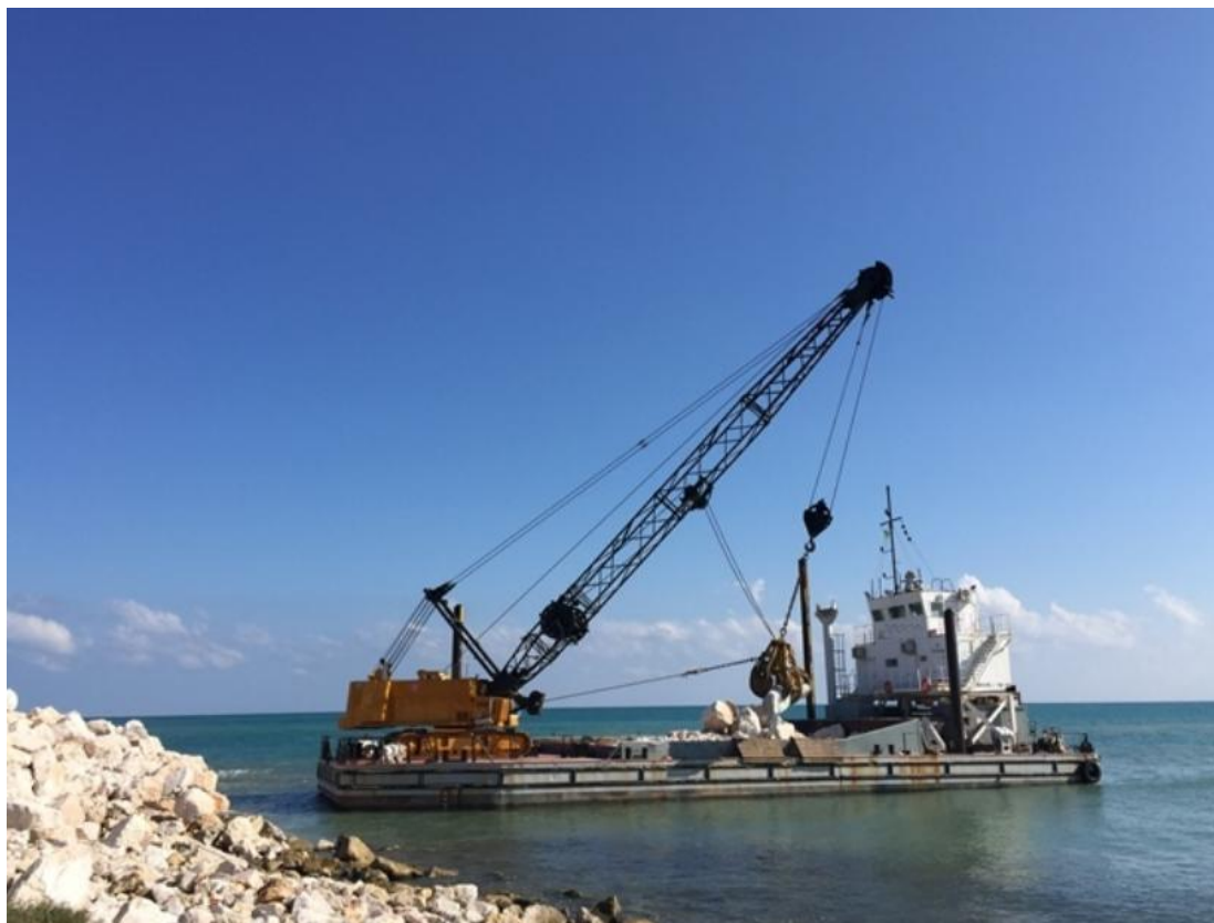
Figura 37: Motopontone salpamento massi
