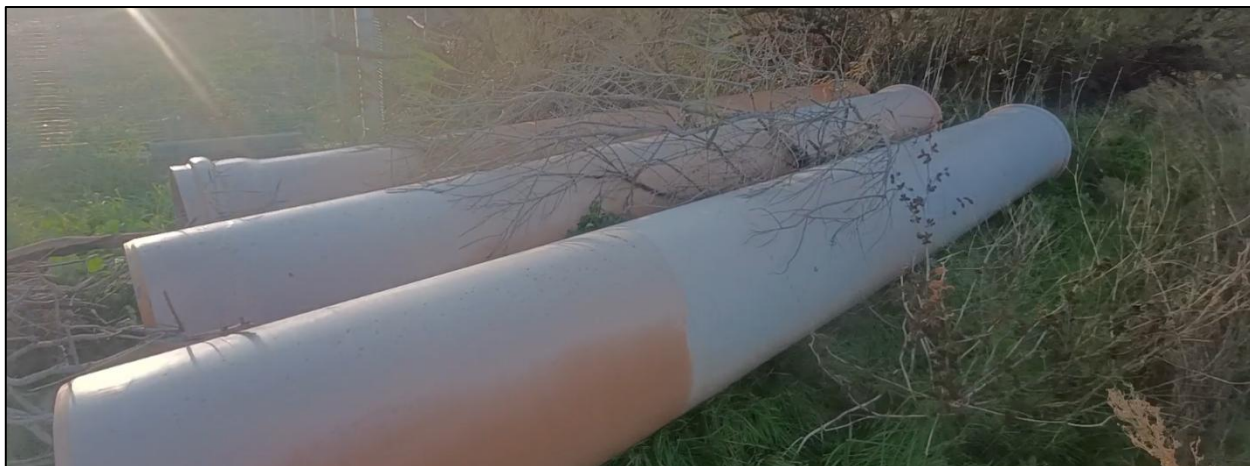
Figura 13: Conci di tubazione venuti meno a seguito delle mareggiate del 7-8 Gennaio 2024
