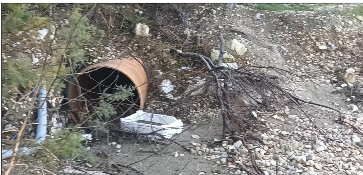
Figura 12: Interruzione del sistema di deflusso arenile da ripristinare con lavori di somma urgenza
