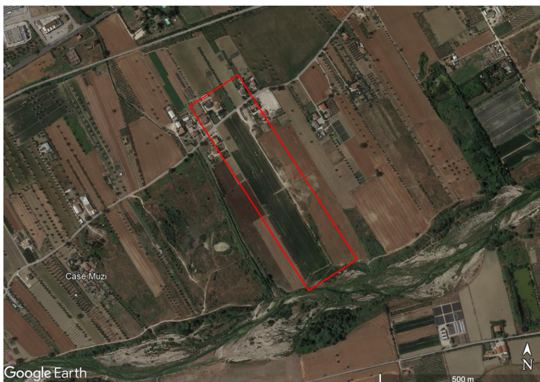
Vista aerea dell'area di intervento
