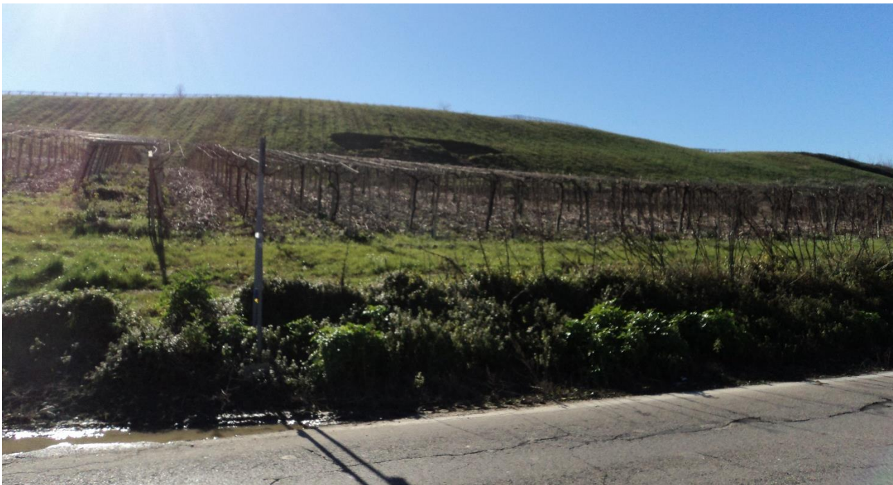
Fig. 16 – Frana in prossimità della S.S.16.
