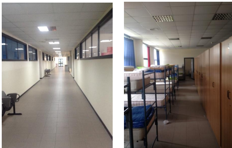
Figura 9. Dettagli degli interni della palazzina con uffici ed alloggi dotati di servizi igienici dell'Interporto di Avezzano (AQ).
