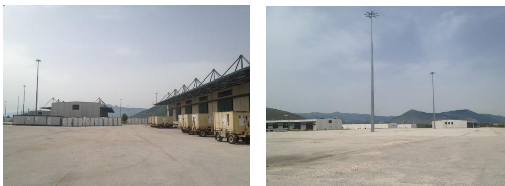
Figura 8. Dettagli delle aree parcheggio e delle strutture adibite a magazzini dell'Interporto di Avezzano (AQ).
