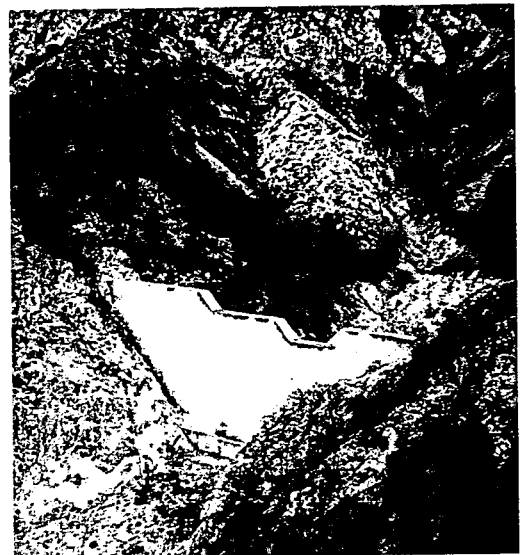
Foto B.3.2.II - Briglia di grosse dimensioni in cemento armato a protezione dell'abitato di Pizzoli (AQ) (C. Crocetti).
