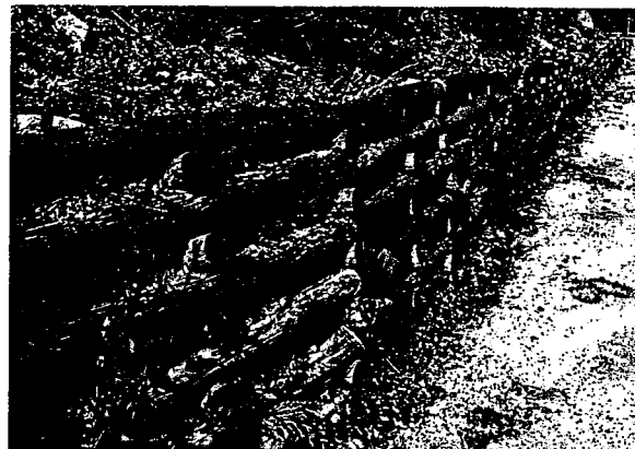
Foto B.5.2.6.VII – Eccessiva pendenza del paramento esterno e posizione allineata dei tronchi trasversi, piuttosto che sfalzata, a discapito della solidità (C. Crocetti).
