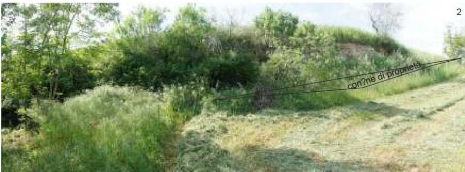
Particolare del con?ne a scarpata arti?ciale che sarà eliminato al termine dei lavori
