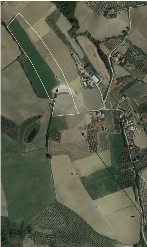
La panoramica sottostante ripresa dallo specchio Nord di incontro tra il lotto 1 e 2 evidenzia la sagomatura a gradoni dei lavori mirata a non alimentare l'erosione in un'area trattata lungo un unico piano inclinato, la disposizione ad arco discendente verso i due estemi dello sbancamento consente il drenaggio delle acque superficiali.
