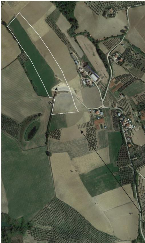
La panoramica sottostante ripresa dallo specchio Nord di incontro tra il lotto 1 e 2 evidenzia la sagomatura a gradoni dei lavori mirata a non alimentare l'erosione in un'area caratterizzata da un unico piano inclinato, la disposizione ad arco discendente verso i due estanti dello scambiacimento consente il drenaggio delle acque superficiali.
