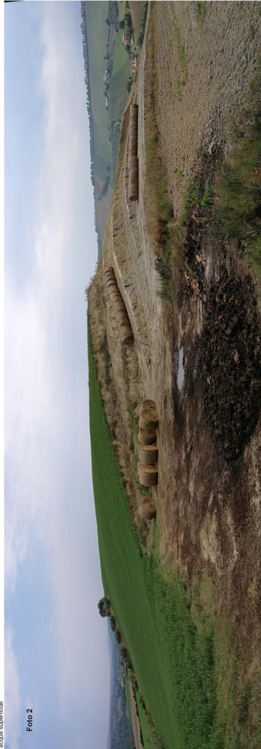
Nella foto a lato si può osservare il rilievo scapoliforme interessato dal progetto e le fasi di lavorazione in corso. Si osservi la pista di accesso, e le scarpate temporanee. La ripresa è stata effettuata in data 09 settembre 2016 e ne attesta l'avanzamento lavori.
