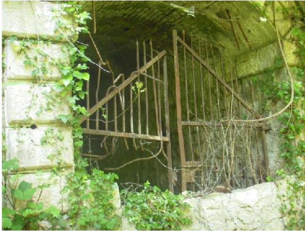
Foto 1 – Accesso galleria ferroviaria
