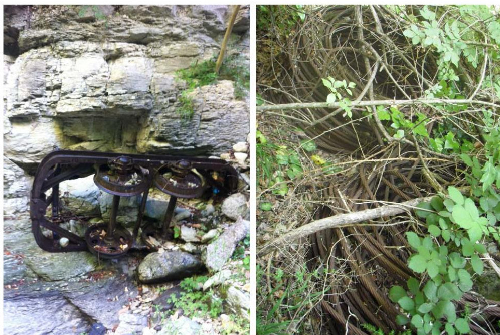
Foto 6 e 7 – Materiale ferroso da rimuovere
