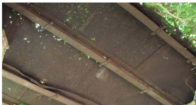
Foto 12 – Particolare della tettoia in lamiera
