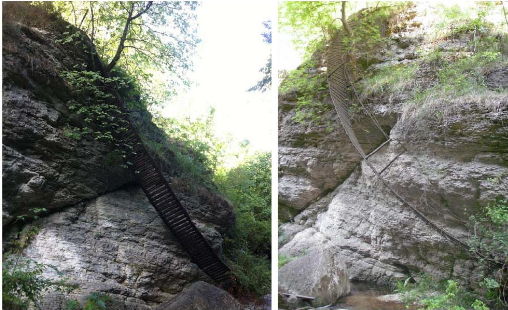
Foto 8 e 9 – Ponte in ferro sospeso (vista da S e da N)
