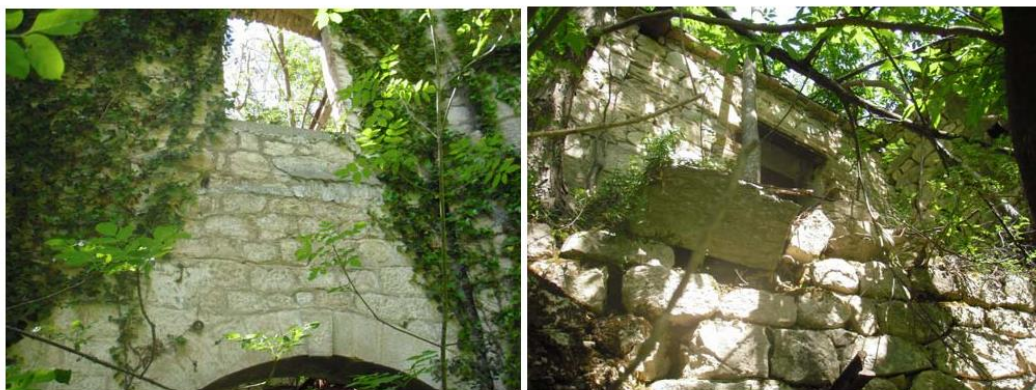
Foto 4 e 5 – Fabbricato in muratura
