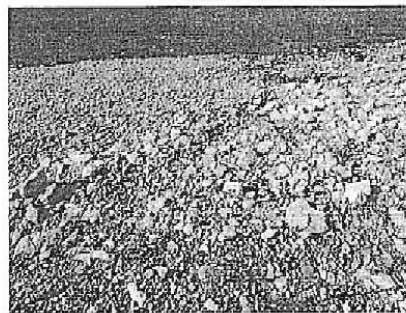
Foto 2- opera (materassino tipo reno) distrutta dalla corrente
