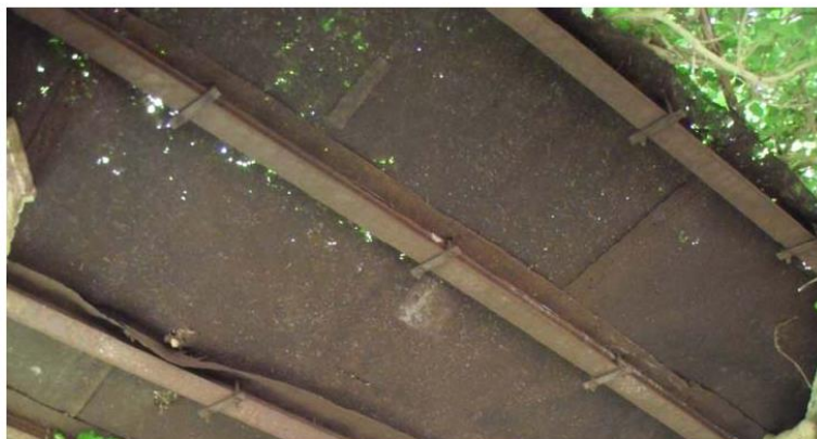
Foto 12 – Particolare della tettoia in lamiera
