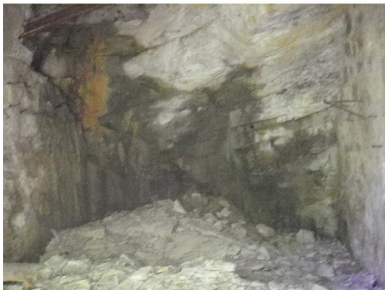
Foto 3 – Interno della cavità in roccia
