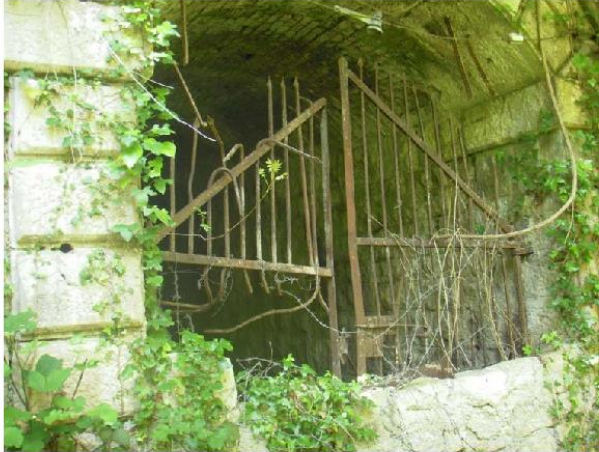
Foto 1 – Accesso galleria ferroviaria
