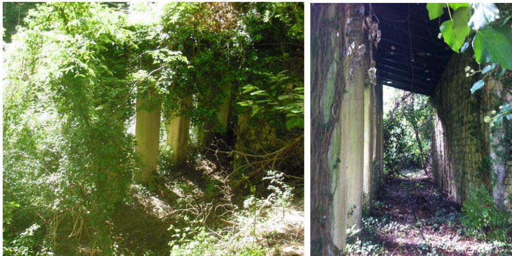
Foto 10 e 11 – Struttura (vista da S e da N)
