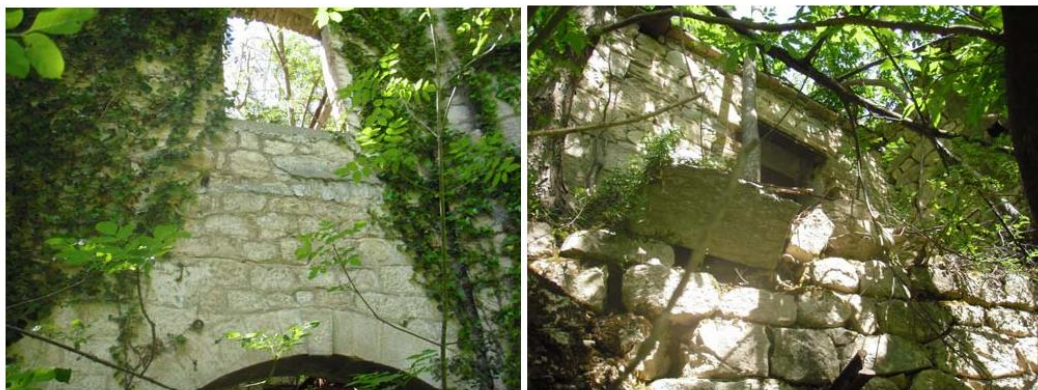
Foto 4 e 5 – Fabbricato in muratura
