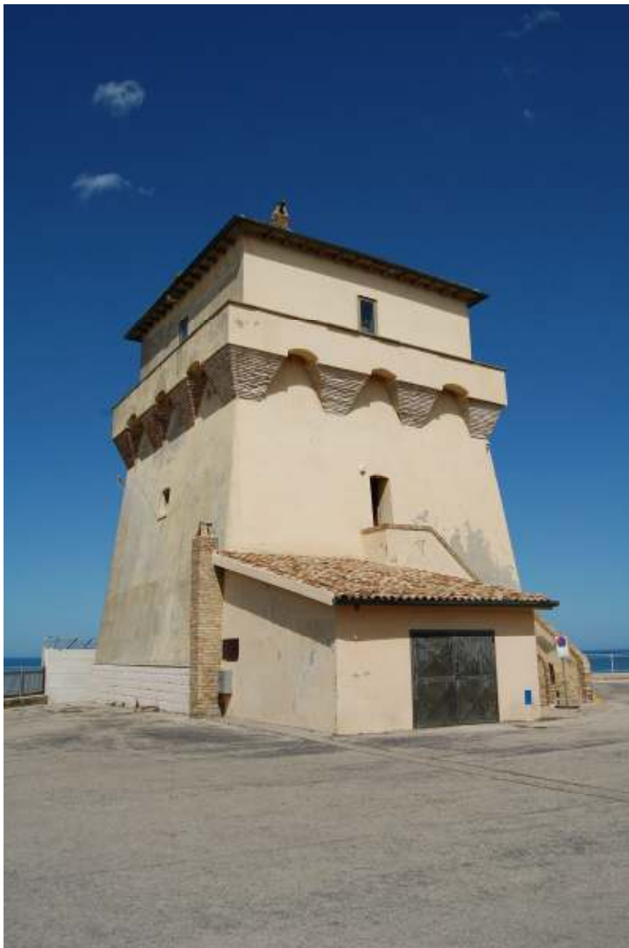
Figura 10.4.1-1 Torre della Punta della Penna
