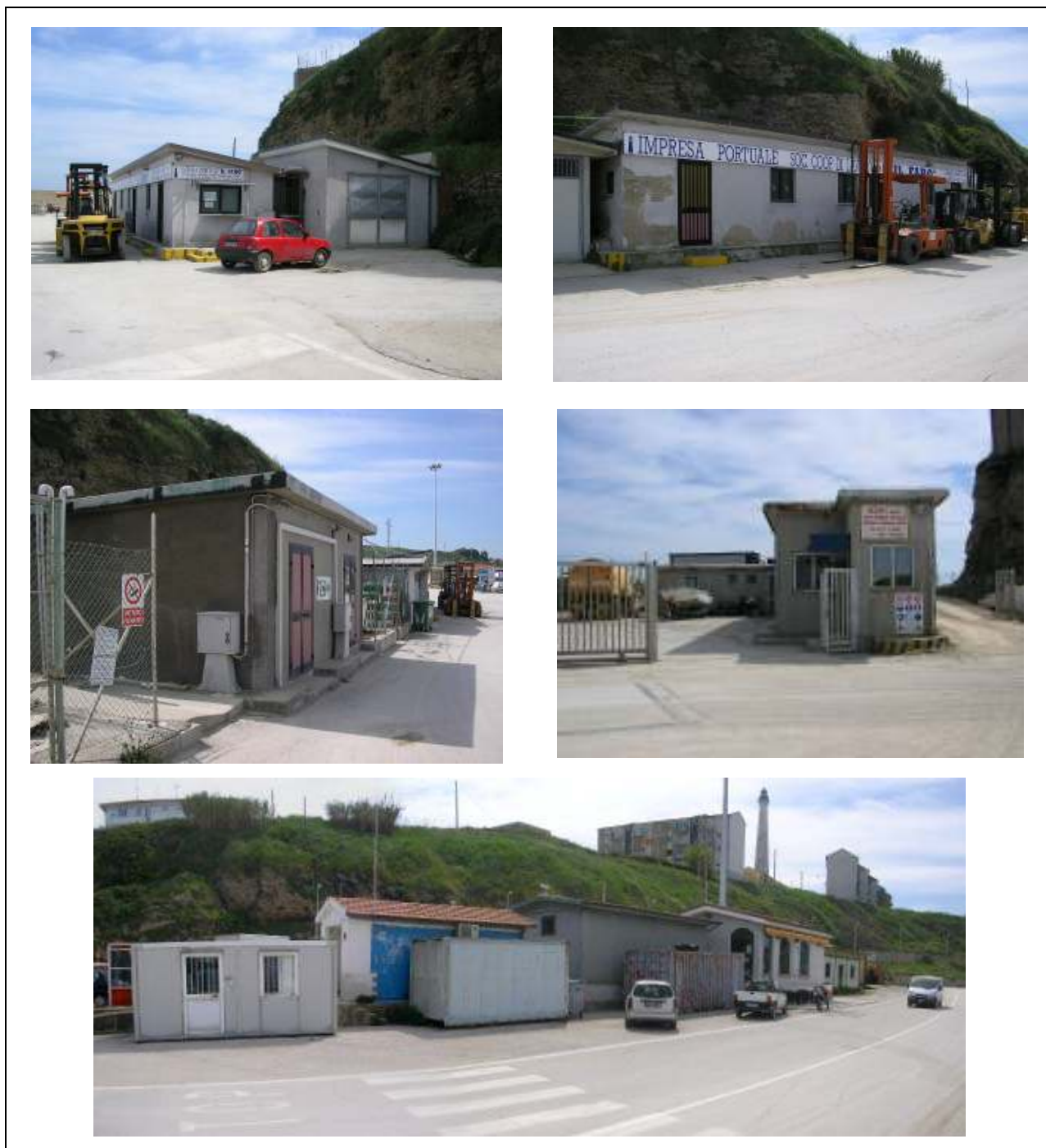
Figura 10.5.1-1 Edifici dell'area portuale
