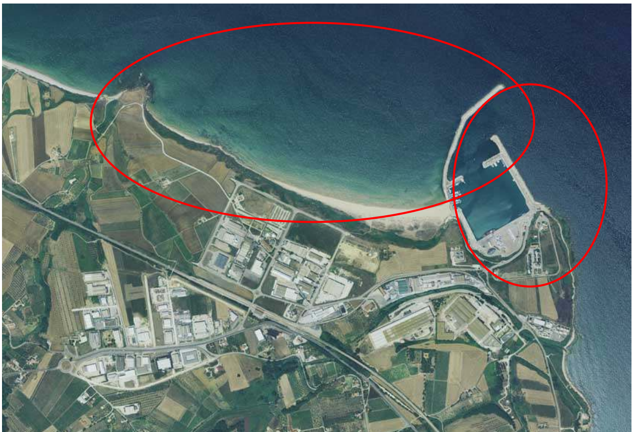
Figura 5.7.3-1 Rappresentazione schematica dei due sub-comparti comprendenti il litorale della Riserva Naturale Regionale Guidata di Punta Aderci e le infrastrutture portuali di Vasto.
