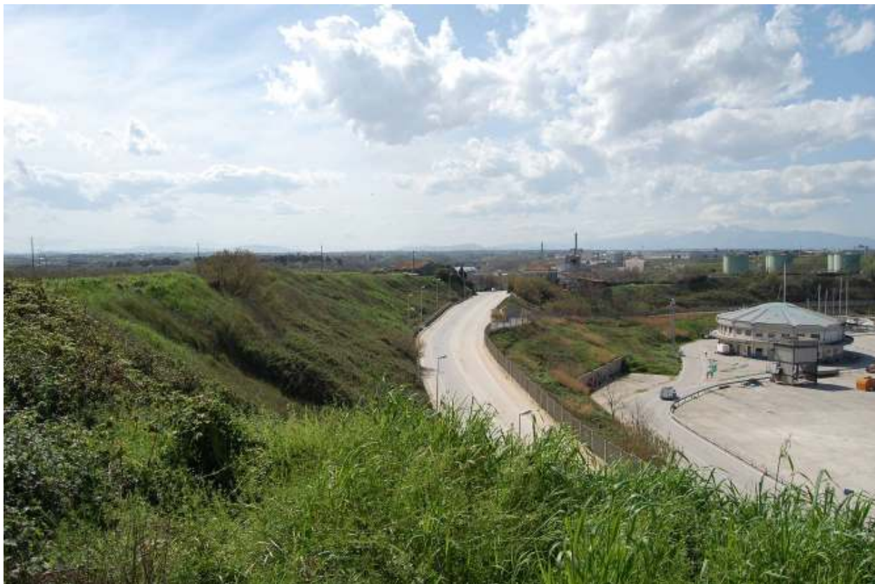
Figura 5.2.3-6 Scarpata di erosione marina in prossimità della strada di accesso al porto.
